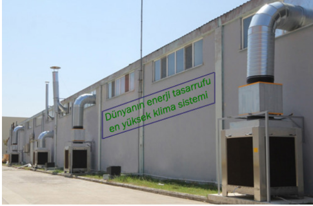
Hemak Nonwoven Üretim Holü HVAC Sistemi (160.000 m³/h) Uygulaması
